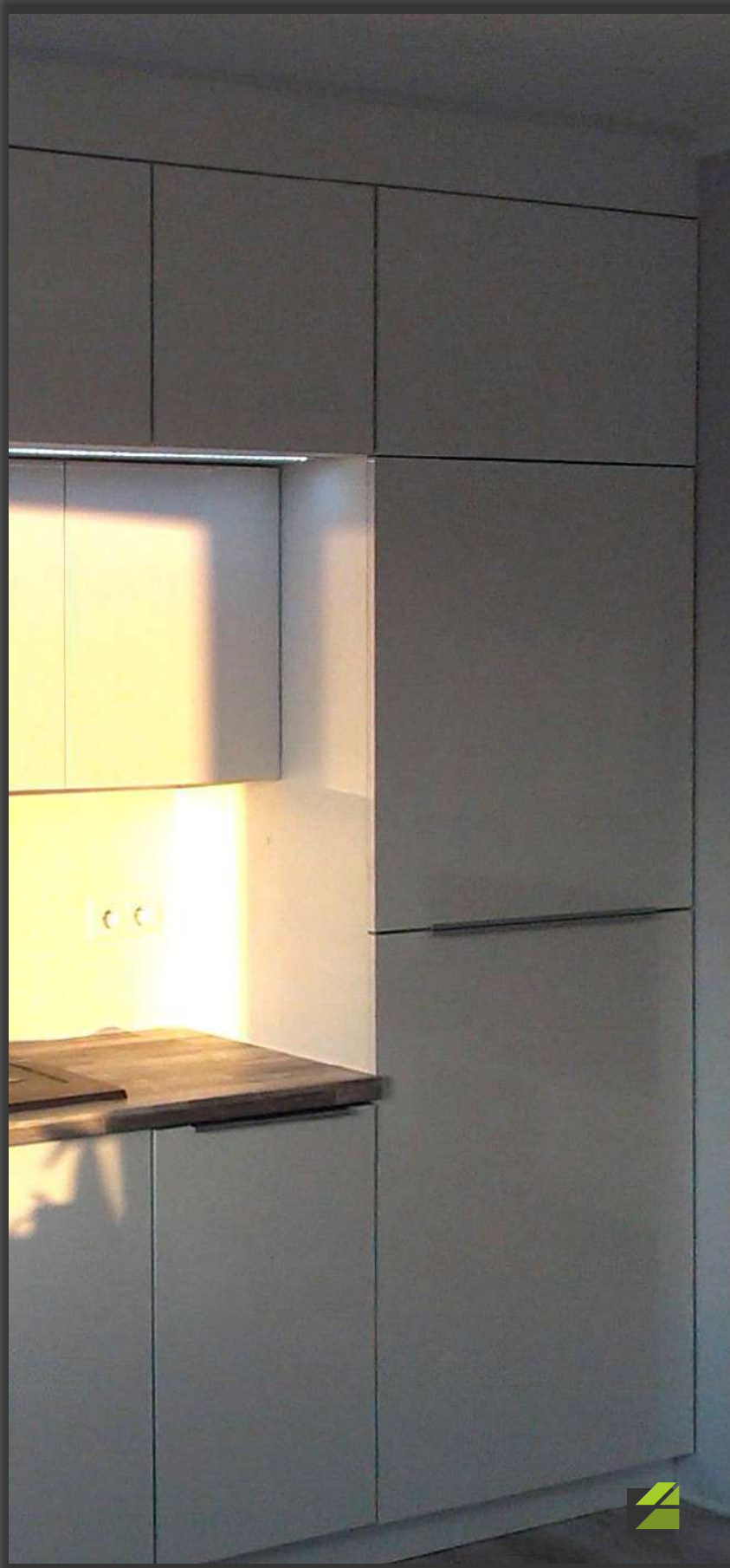
Rys.29.3 Część prawa kuchni po wykończeniu
