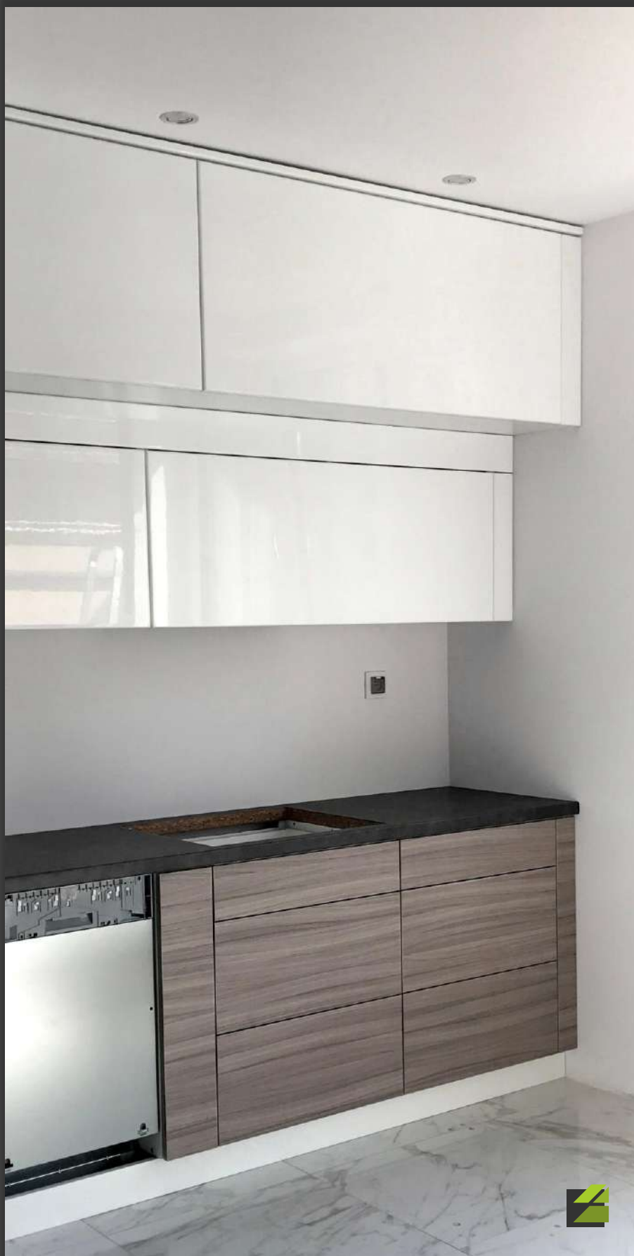
Rys.32.3 Główna część kuchni podczas prac wykończeniowych
