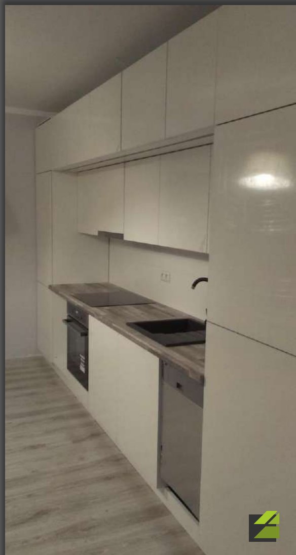
Rys.29.1 Widok kuchni w trakcie prac
